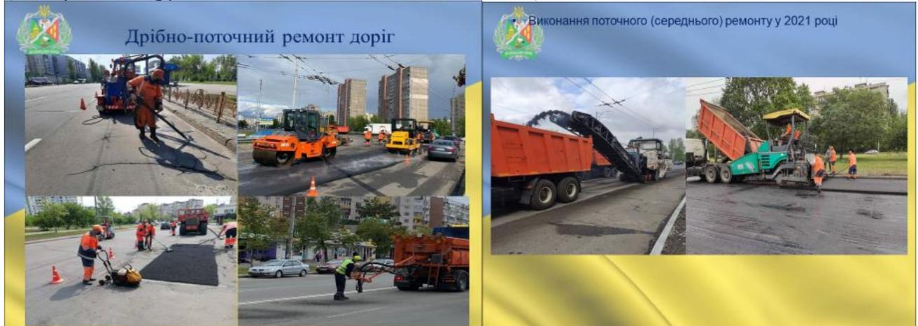
Проведено роботи із заливки тріщин 30 000 погонних метрів асфальтобетонного покриття установкою «Крафко».
